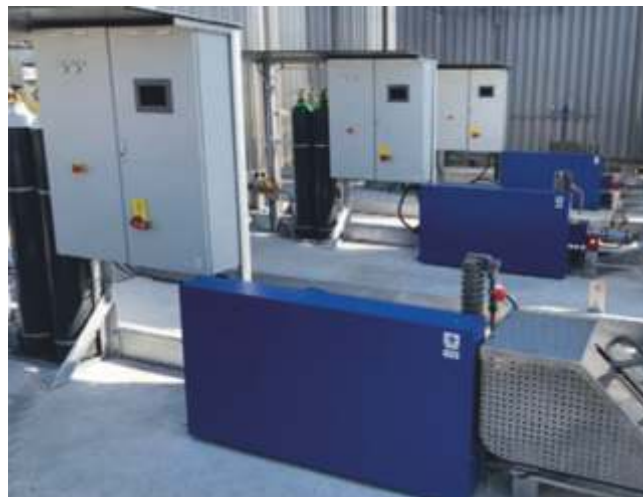
Площадка криогенных насосов в составе автоматической наполнительной станции KRYTEM
