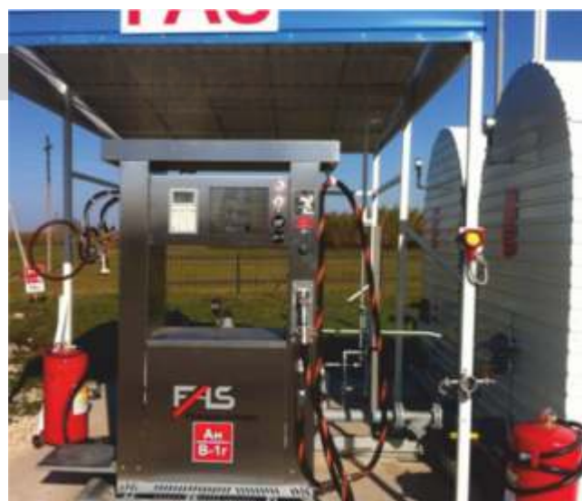
Пример комплексного решения: подача газообразного пропана и наполнение баллонов от ФАСХИММАШ
