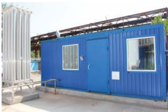
Пример внешнего вида узла приготовления сварочной смеси
